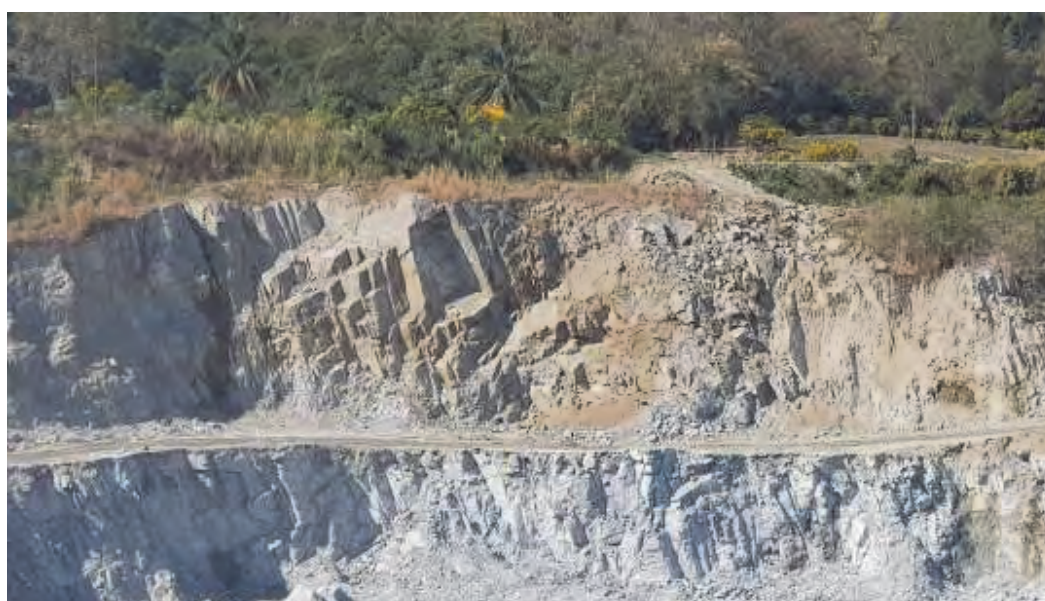
รูปที่ 16 แสดงลักษณะของรอยแตกหลักในหินแกรนิต 2 แนวตัดกันทำให้เกิดการแตกในลักษณะเป็นบล็อก (Block slide) (พิกัดภาพถ่าย 1467568 N/728990 E มุมมองไปทาง SW)
